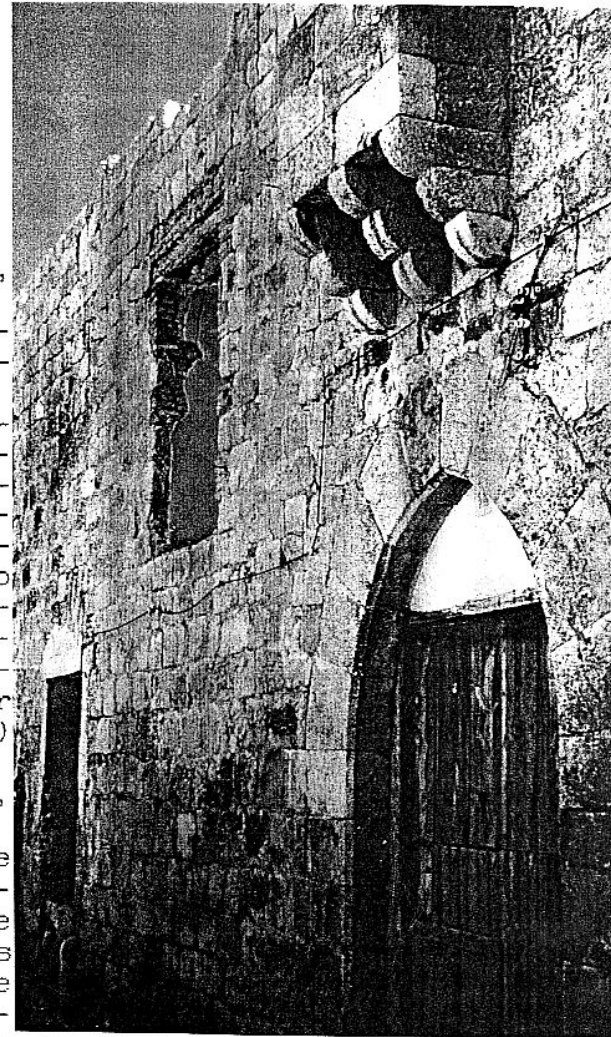
Castillo de Grisel. Detalle de la puerta y el matacán.
