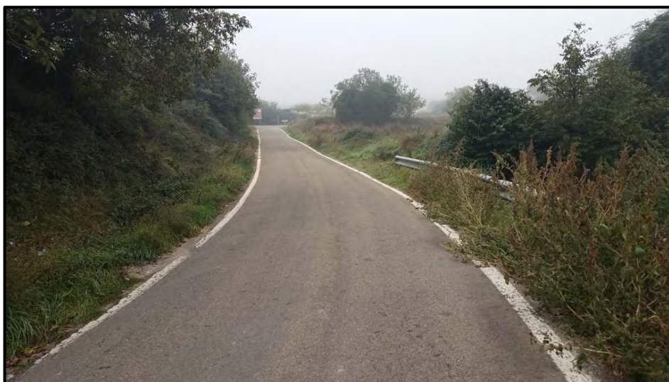
La carretera CV-678 desde el empalme con la N-122 hasta Grisel fue arreglada en el año 2016. Este tramo pertenece a la antigua carretera Malón – Grisel. Y en esta fotografía se puede ver la carretera antigua llegando al pueblo. ARCHIVO A.C. LA DIEZMA
