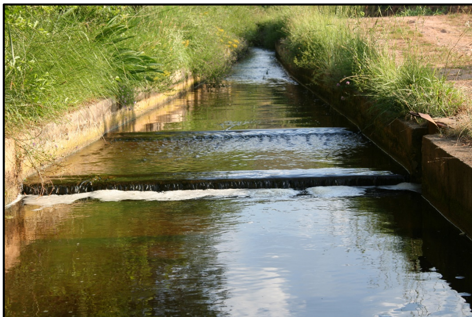
Cauce de la acequia de Irués a su paso por Grisel.
