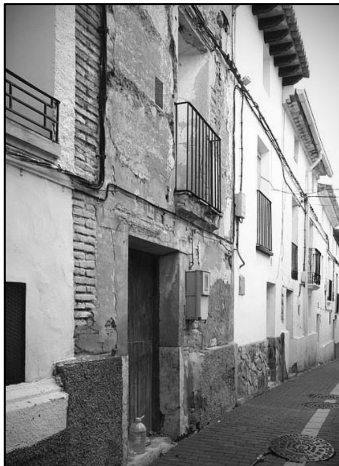
Calle Casas Nuevas
