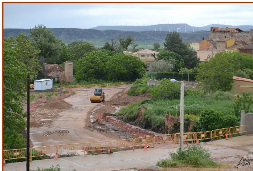
Vista de la nueva variante de entrada desde la zona de Cahises.
