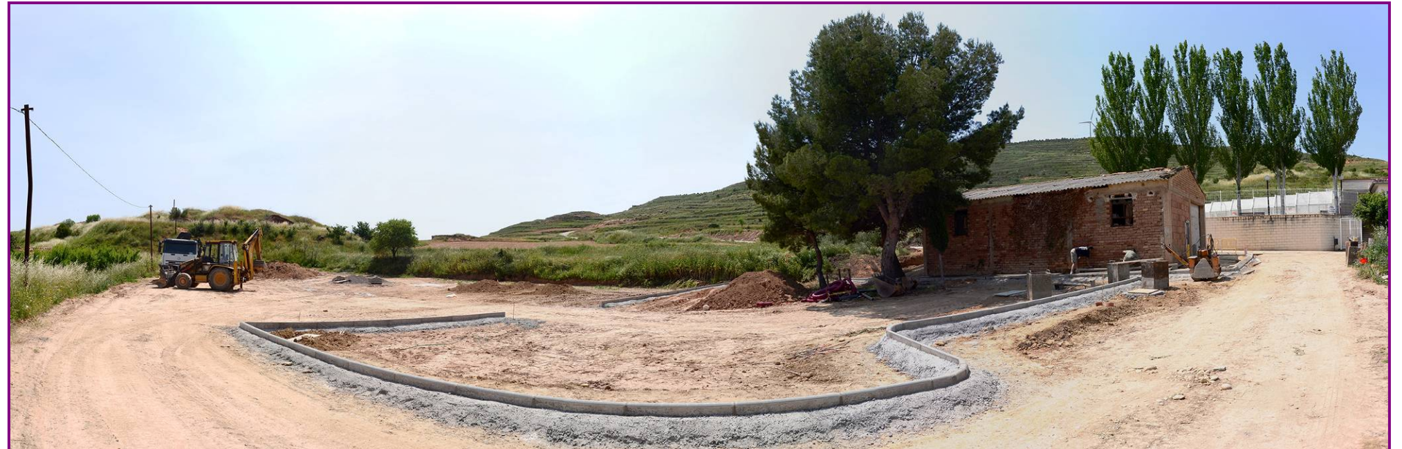
Parte posterior de la nueva zona de ocio, donde se instalara en una segunda fase una zona de acampada para autocaravanas, con barbacoas, mesas, bancos etc.
