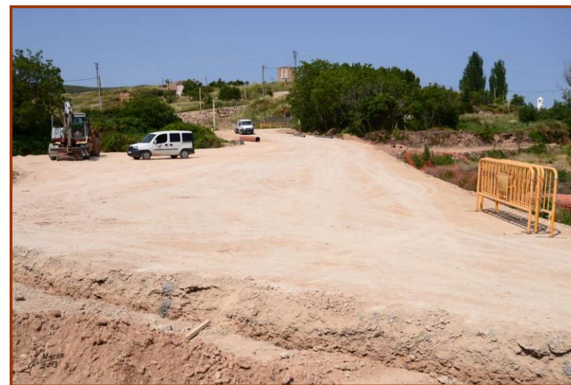
Vista general desde la entrada de la carretera en Grisel.
