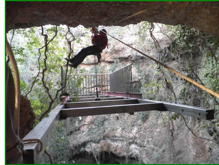
7.- Montaje de la nueva plataforma en el mirador del pozo.
