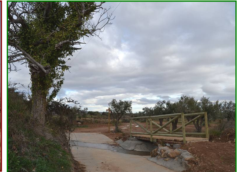
4.- Puente que cruza la acequia de Irués al llegar el camino a la finca de olivos donde se encuentra el pozo de los Aines.
